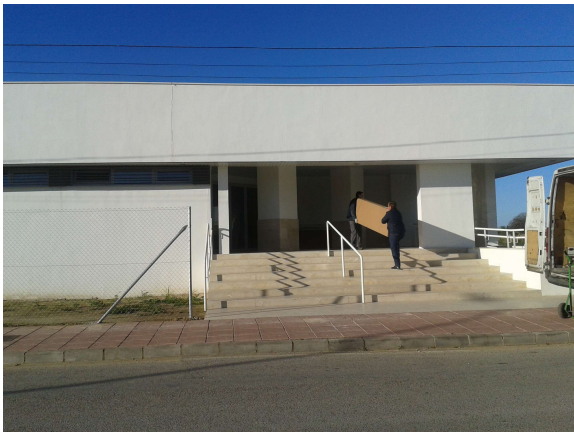
Exterior Unidad Estancia Diurna
