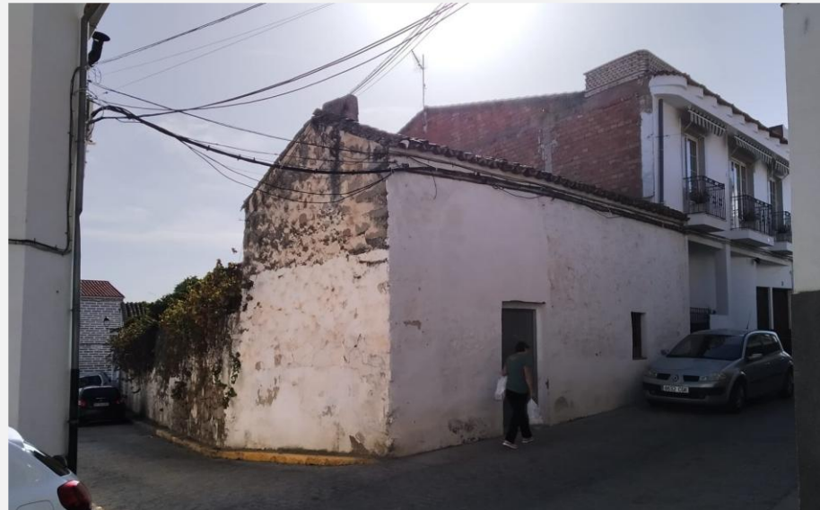
Edificio que se pretende destinar a Consultorio médico en Pedroche.
