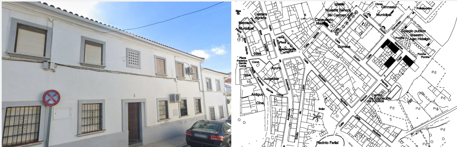
Vivienda tipo bloque zona oeste de Cardeña y plano con las 6 viviendas donde se va a intervenir.
